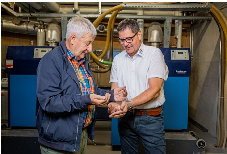
Hans Gasser und Curdin Accola zeigen, wie aus etwas Kleinem etwas Grosses entstehen kann: ein Wärmeverbund für grosse Teile des Dorfs.
