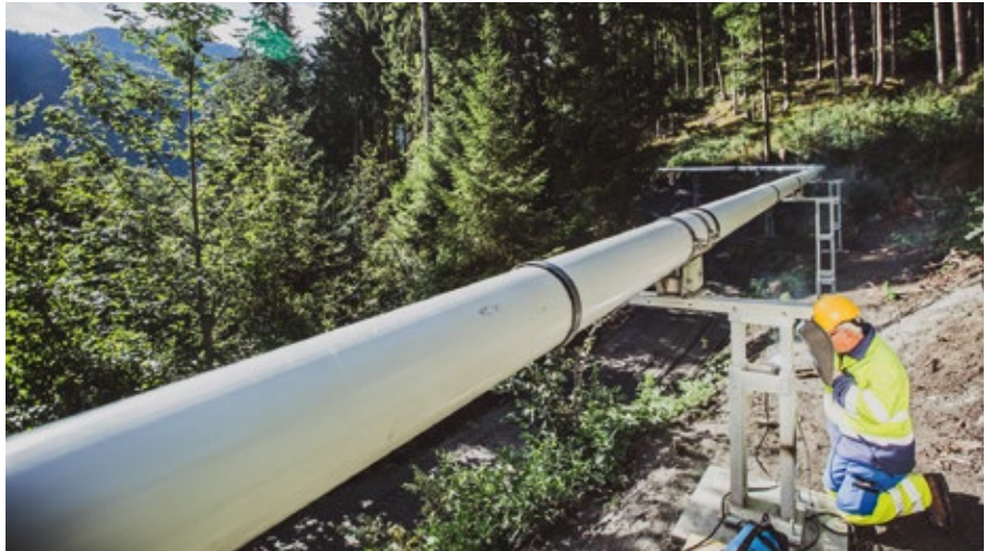
Die Trinkwasserleitung im Gebiet Erlenrutsch wird auf ein spezielles Trägersystem montiert.
