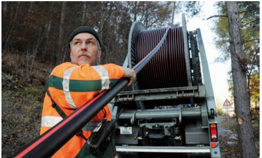
Kabeleinzug am St. Antönienweg durch ERAG.
