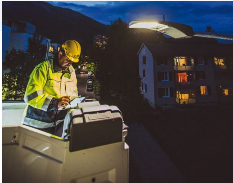
Die ersten LED-Strassenlaternen wurden bereits auf dem Churer Stadtgebiet installiert.
