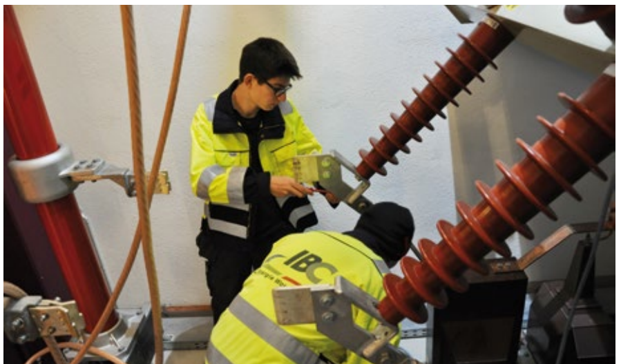
Abschlussarbeiten in der 60-kV-Schaltzelle im Unterwerk Sand.
