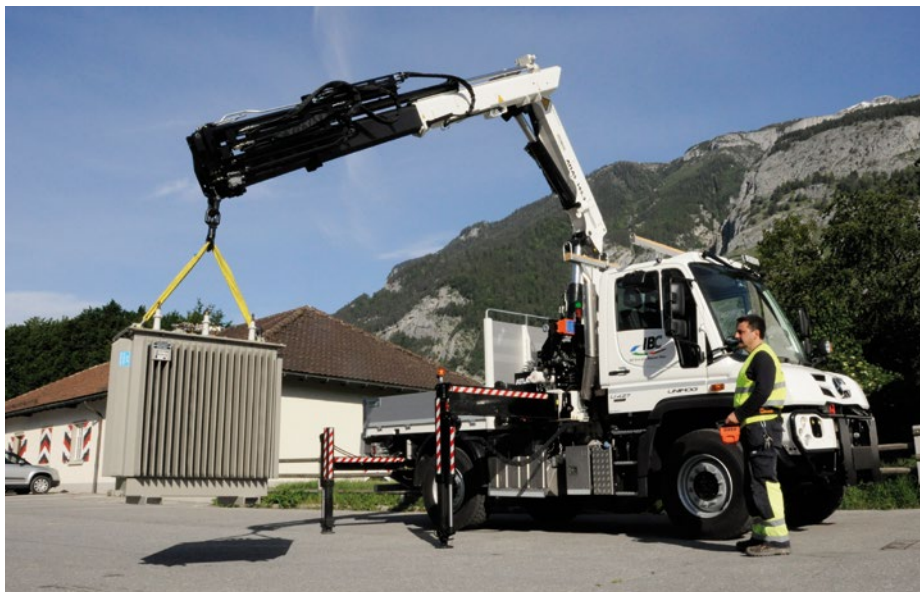
Kurt Grossmann beim Abladen eines Transformators.
